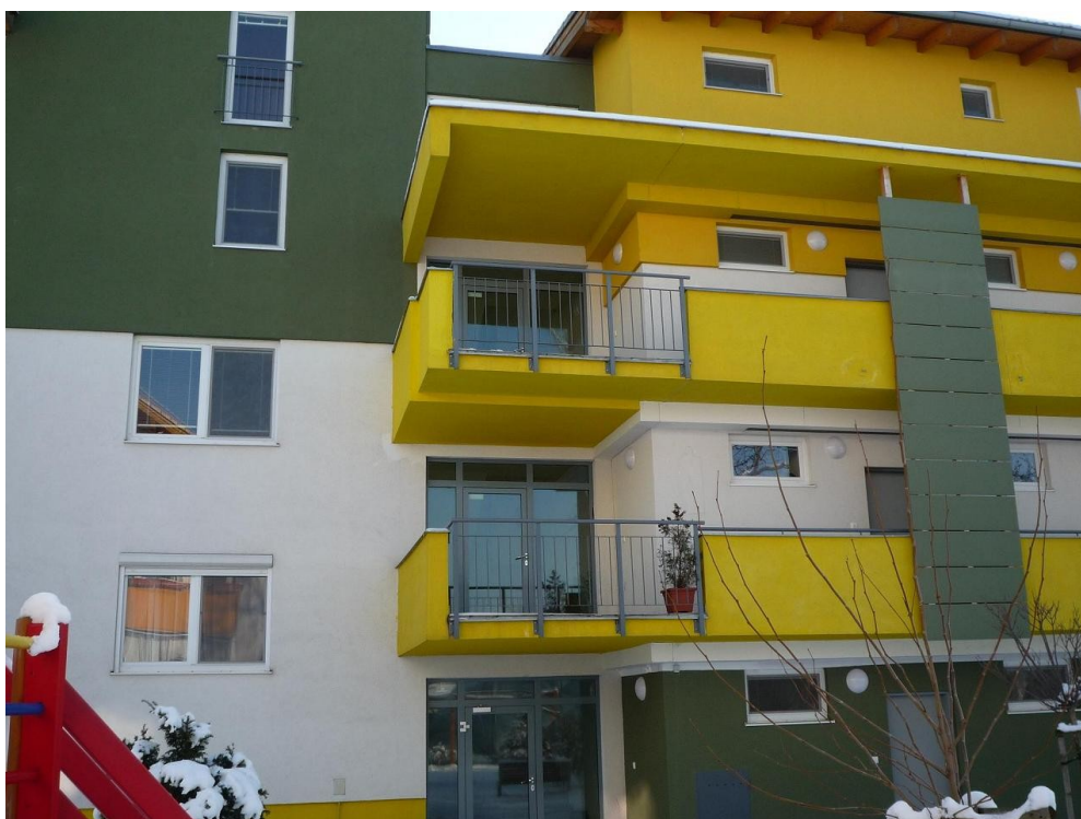
Obr. č. 1 : Hlavná budova – severná strana
